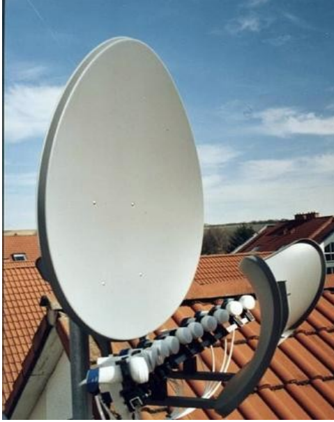
Toroidal çok LNB'li anten (multi-lnb dish)
