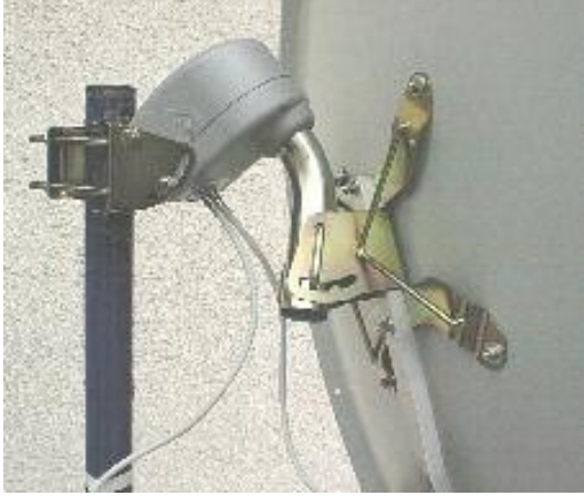
DiSEqC motorlu hareketli anten
